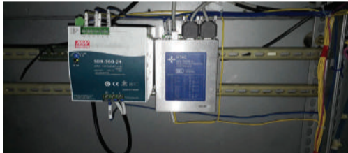
АРОЛ автоматикийн мэдээлэл хөрвүүлэгч төхөөрөмж суурилагдсан байдал
