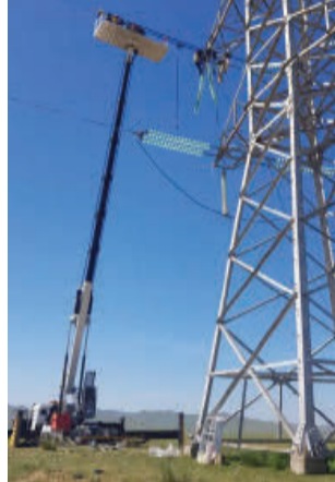
Тулгуур № 135-136 хооронд хуучин утсыг шинэ утастай холбож залгаа хийж байгаа байдал
