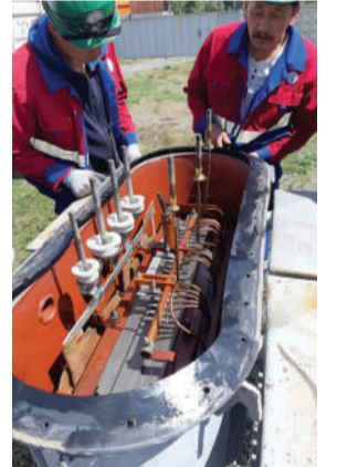
110/10/6 кВ-ын Өмнөд дэд станцын ДХТ-1 их засварын ажил
