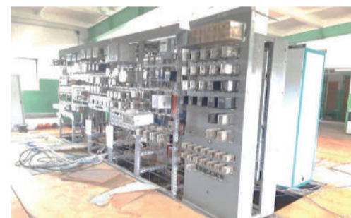
ОПУ-д хамгаалалтын 9 панель буулгасан. Хамгаалалт, удирдлага, дохиоллын хэлхээ нь 5 панелд суурилагдсан.
