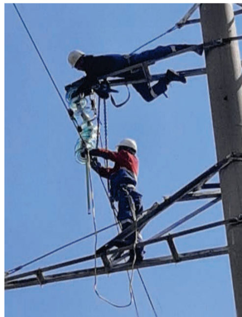
нэвт цохигдсон элемент, утасны судал тасарсан гэмтлийг тус тус устгасан.
