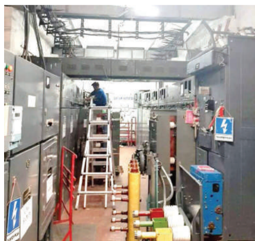
6 кВ-ын II секцийн ячейкуудыг шинэчилсэн байдал
