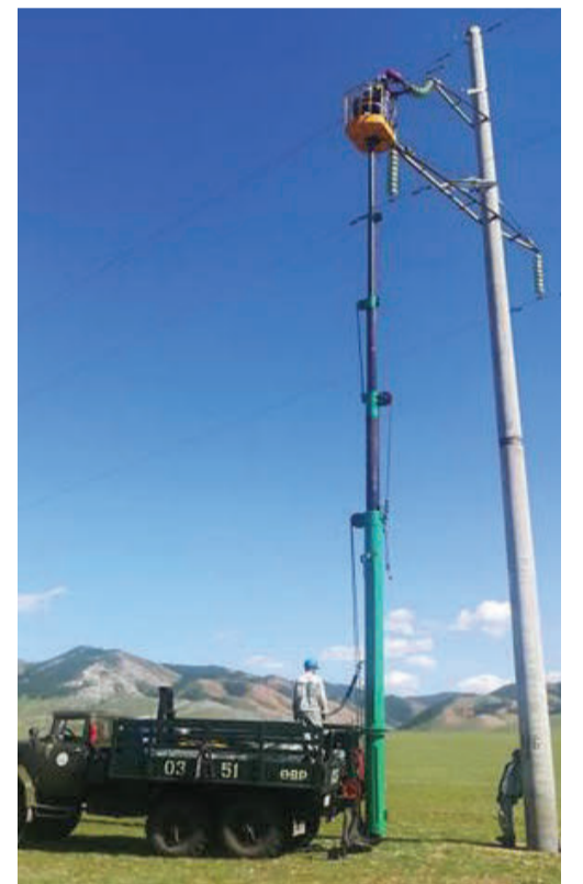
нэвт цохигдсон элемент, утасны судал тасарсан гэмтлийг тус тус устгасан.
