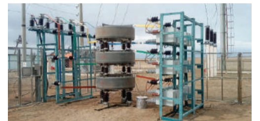
Баянтээг дэд станцад 10 кВ-ын компенсатор суурилуулсан байдал
