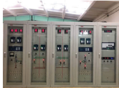
ОПУ-д хамгаалалтын 9 панель буулгасан. Хамгаалалт, удирдлага, дохиоллын хэлхээ нь 5 панелд суурилагдсан.
