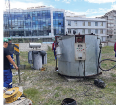
110/10/6 кВ-ын Өмнөд дэд станцын ДХТ-1 ороомгийг сушилк-д хатаах ажил
